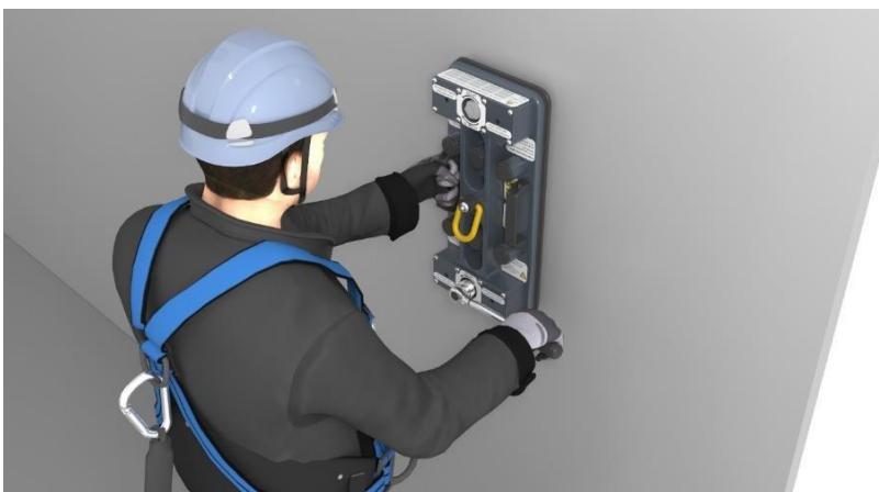
Arbeiter bei der Montage des P-Tools
