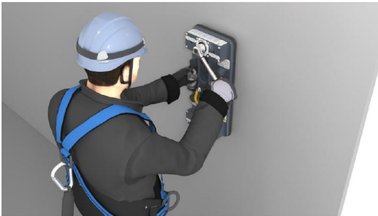
Arbeiter bei der Montage des P-Tools
