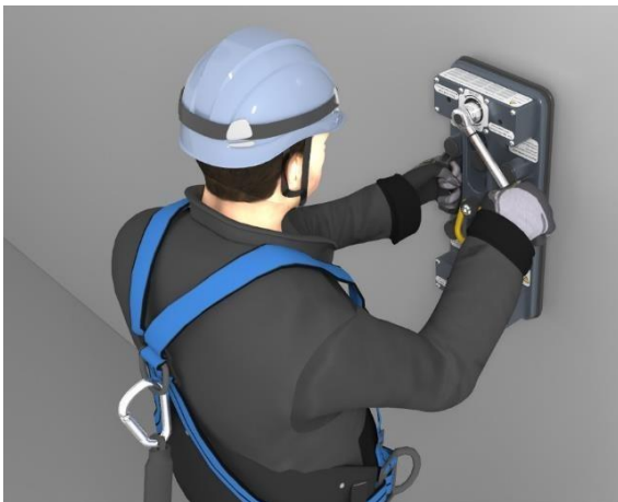
Løsn begge sekskanthoveder på støttebenene
